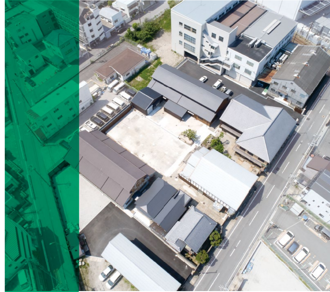
久金属工業本社全景(令和2年)
