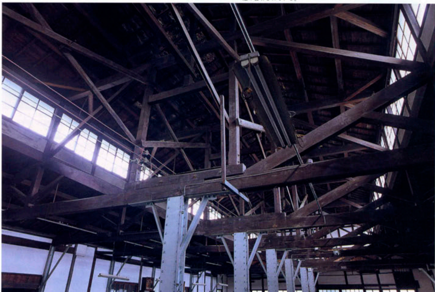
第3工場内部 中央の柱に鉄骨を使うほかは木造。屋根を支える構造は、三角形に斜めにのびる木材(洋小屋)と水平垂直の木材からなる部分(和小屋)が組み合わされている。
