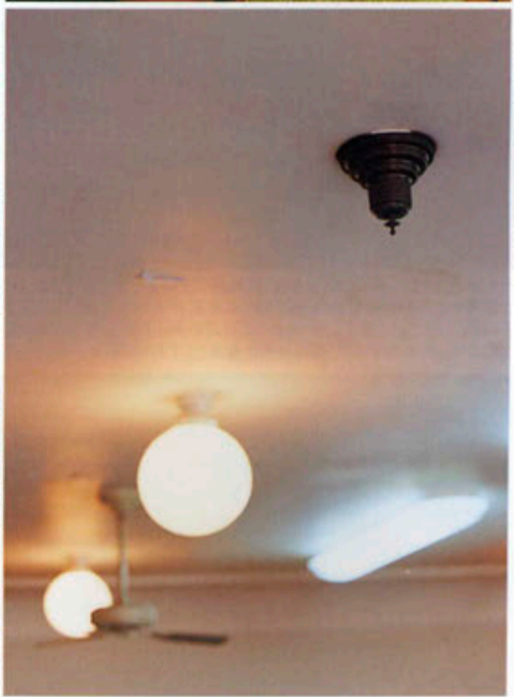
上●応接室扉 扉のガラスと板壁。マーブル模様のように見える板は、上からペンキで模様を描いたもの。事務所棟2階では随所にこの仕上げが施されている。 下●会議室の天井 手前のベルのようなものは電気の中継ボックス。白漆喰を背景に存在感が際立つ。
